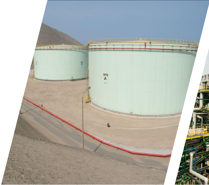
Tanques de Diésel
